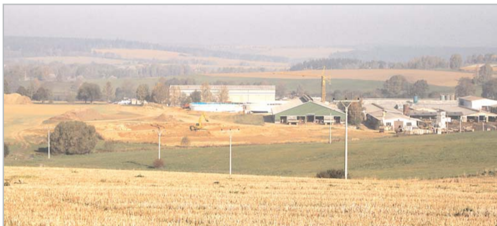
Stavba bioplynové stanice je v plném proudu
