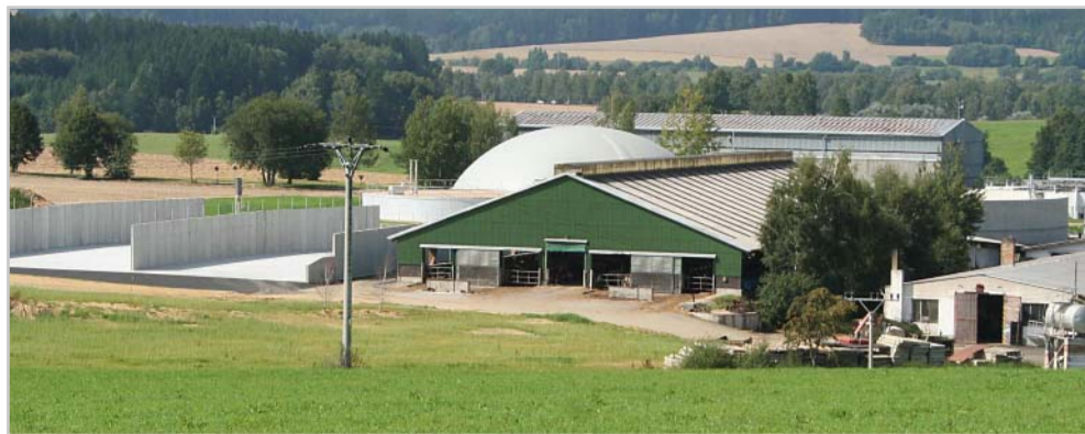
Technologický komplex ve Věžné – objekty pro ustájení skotu, nové silážní žlaby, bioplynová stanice a loupárna brambor
