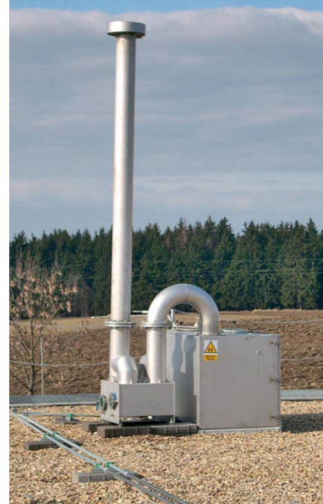
Patentovaná servisní šachta s glykolovou přetlakovou pojistkou, která umožňuje servis míchadel bez přerušení provozu stanice
