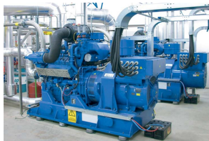
Dvě kogenerační jednotky DEUTZ jsou chloubou stanice
