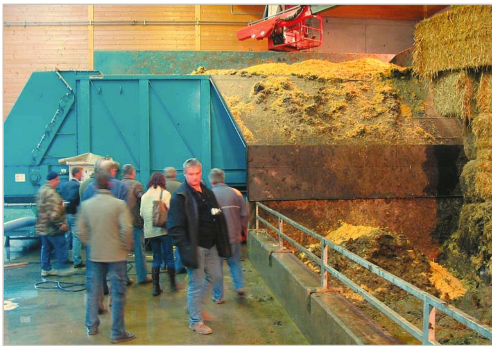
Hnůj se dováží do příjmové haly a portálovým jeřábem se překládá do robustního dávkovače
