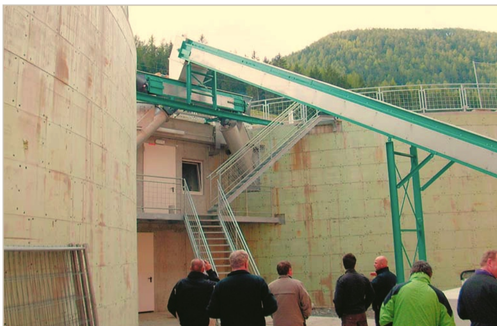
Doprava neupraveného slamnatého hnoje musí být řešena robustními dopravníky a speciálními vkladacími šneky
