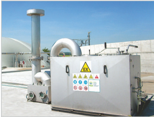
Přístup k hydraulickému míchadlu je zajištěn pomocí servisní šachty Foto archiv firmy
