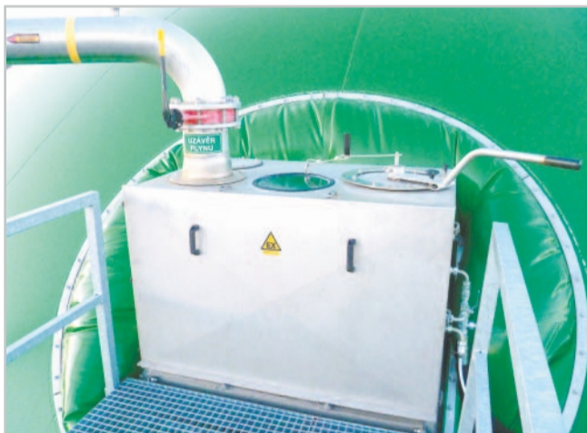
Servisní šachta instalovaná na dvouvrstevném plynovém stropě Foto archiv firmy
