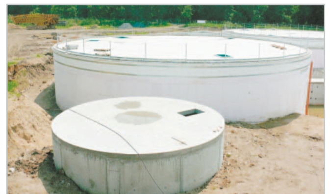
Při výstavbě fermentoru s betonovým stropem je třeba dbát na dokonalou tepelnou izolaci – detail z výstavby
