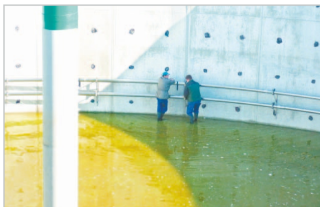
Detail montáže topného potrubí z nerez
